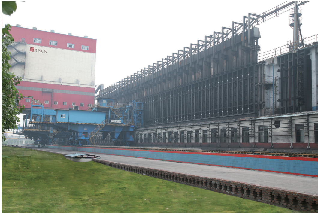
定州生產園區的焦炭生產設施
